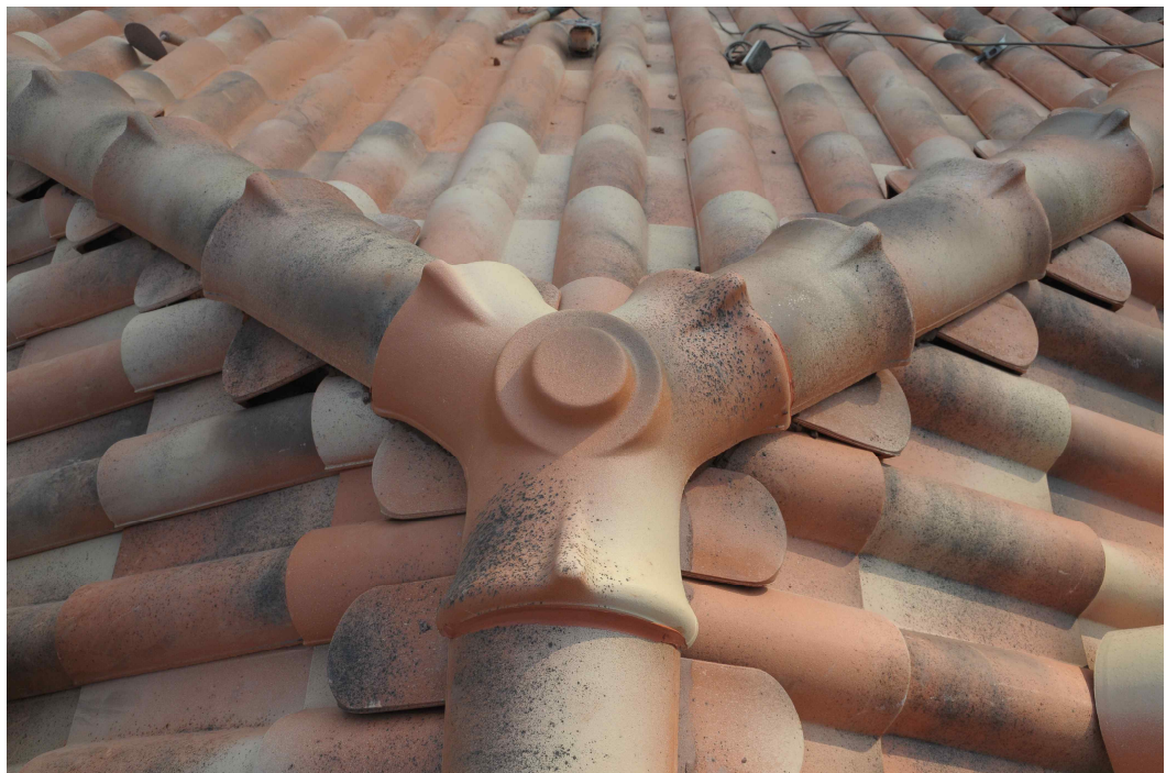
삼방향 기와가 설치된 지붕 형태
