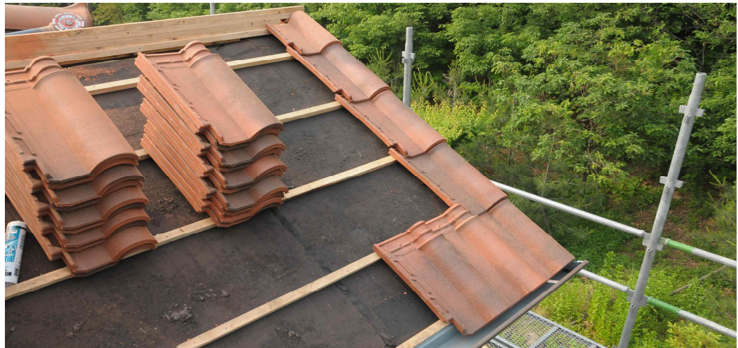
바닥기와 시공 형태
