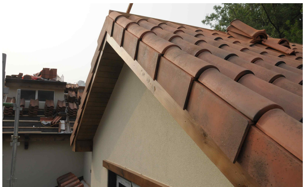
갓기와가 설치된 지붕 형태
